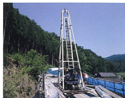
図-5 作業構台上からの施工
