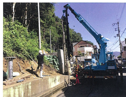
図-4 揚重機械による直接施工
