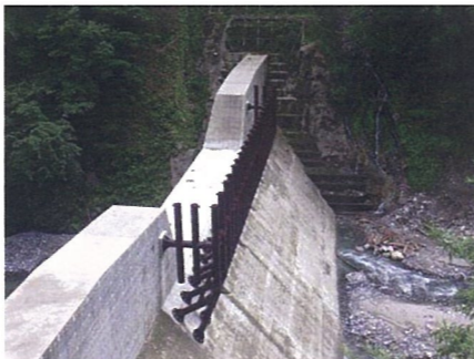
写真-2 未満砂状態からの設置例
