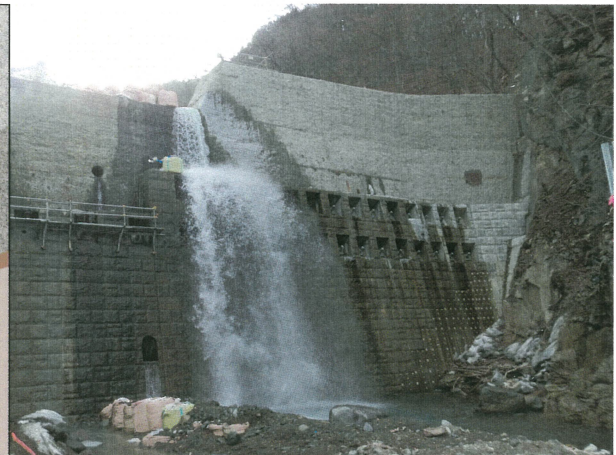
砂防堰堤補強例
