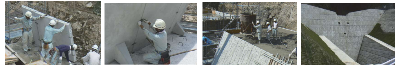
ブロック設置全景 背面取り付け金具の設置 堤体コンクリートの打設 完成
