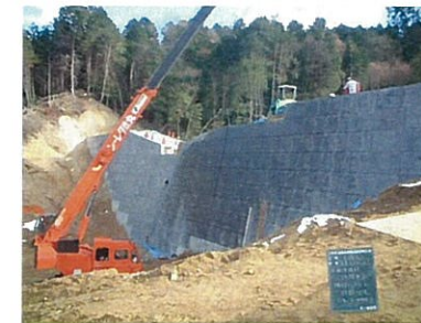
BSBブロック設置全景
