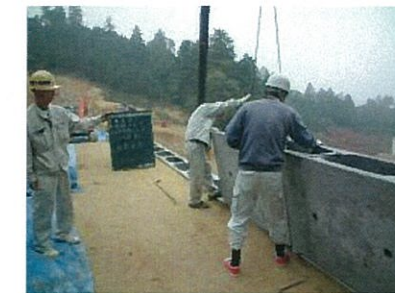
ブロック設置
