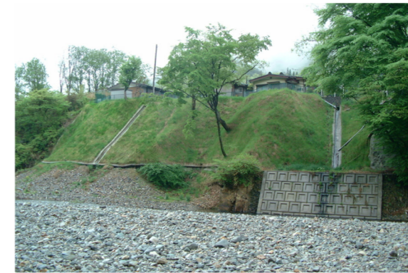
河川護岸の施工例
