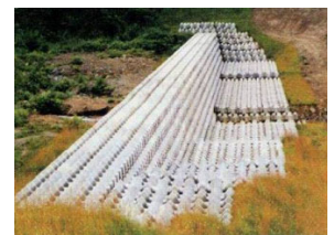
コンクリートブロックえん堤
