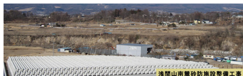
コンクリートブロックの備蓄(浅間山)
