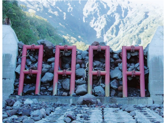
砂防堰堤（B型） （北海道稚内建設管理部管内；雄忠志内川）
