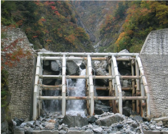
砂防堰堤（格子形） 南股第4号砂防堰堤 （松本砂防事務所管内；長野県北安曇郡白馬村）
