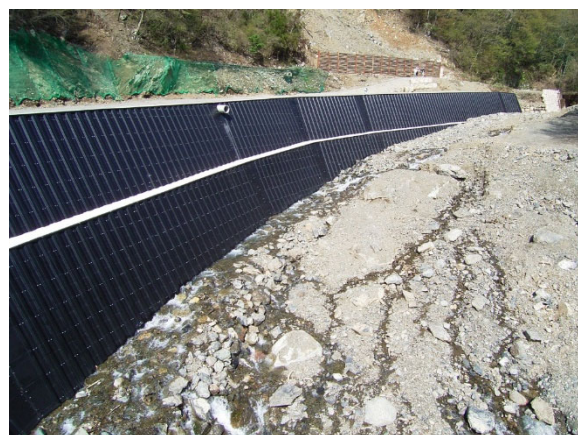
にがこべ谷川溪流保全工 (川辺川ダム砂防事務所管内；熊本県八代市)
