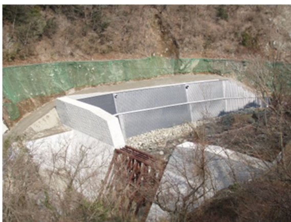
にがこべ谷川溪流保全工 (川辺川ダム砂防事務所管内；熊本県八代市) ※砂防ソイルセメント施工便覧(平成28年版)より抜粋
