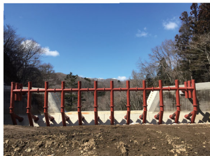
張出しタイプの施工事例（満砂型、未満砂型）
