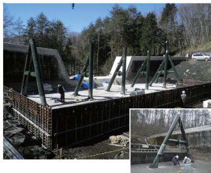
張出しタイプの施工事例（満砂型、未満砂型）
