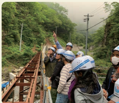
仮設の足場も何のその！ (華厳上流砂防堰堤整備事業)
