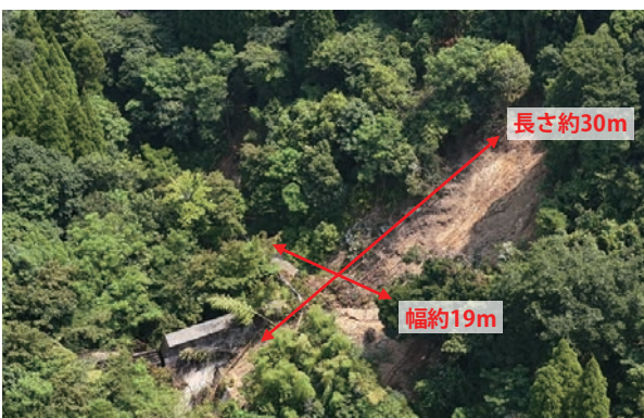
図-10 斜面崩壊の状況(上空より撮影)
