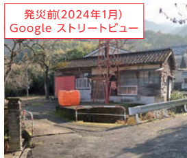
図-6 岡町谷川集落の被害状況
