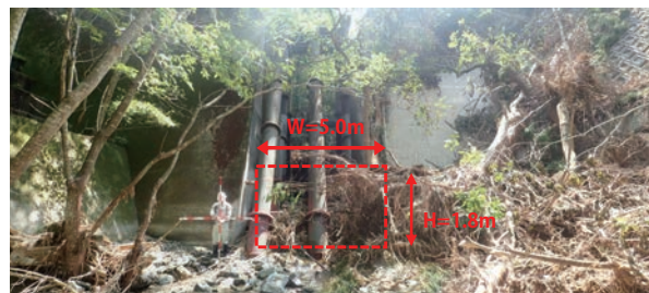
図-17 ピーク流量推定箇所(岡谷川砂防堰堤)
