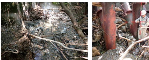
図-9 透過型砂防堰堤の堆砂域及び捕捉状況
