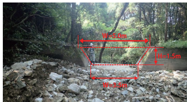
図-18 ピーク流量推定箇所(大谷川砂防堰堤)
