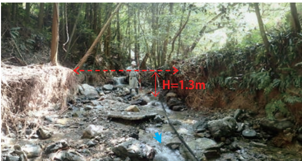
図-8 高速道路より上流の河道の状況(岡谷川)
