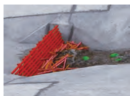
JDフェンス 巨石・流木を確実に捕捉
