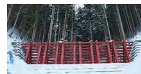
設置事例(国土交通省; 広島県)H=5.0m
