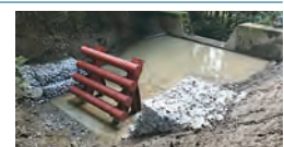
設置事例(宮城県) H=2.0m
