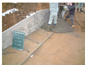
袖天端保護コンクリート打設
