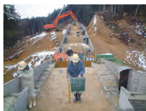
残存型枠パネル設置
