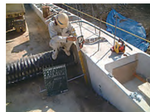
背面木製型枠脱型
