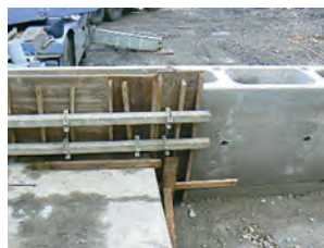
背面木製型枠状況(左：連結筋有 右：連結筋無)
