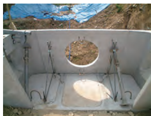
前面残存型枠パネル状況
