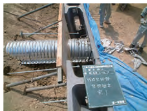
背面木製型枠状況(左：連結筋有 右：連結筋無)
