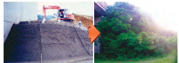
施工中(長繊維混入補強土吹付工)
