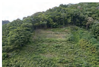
岩手県：維持管理対策 高耐食・点検性能
