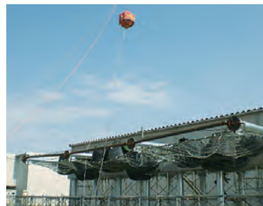
実験状況 (実規模衝撃載荷実験)
