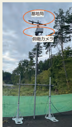
図-9 中継基地局の設置状況
