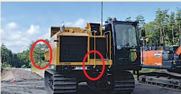
図-13 カメラ設置状況(キャリアダンプ)
