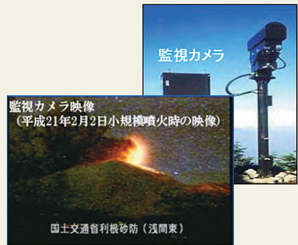
図-7 CCTV監視カメラの設置状況
