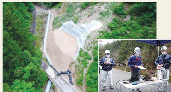
図-12 UAVリアルタイム配信(百々之木谷第1砂防堰堤)
