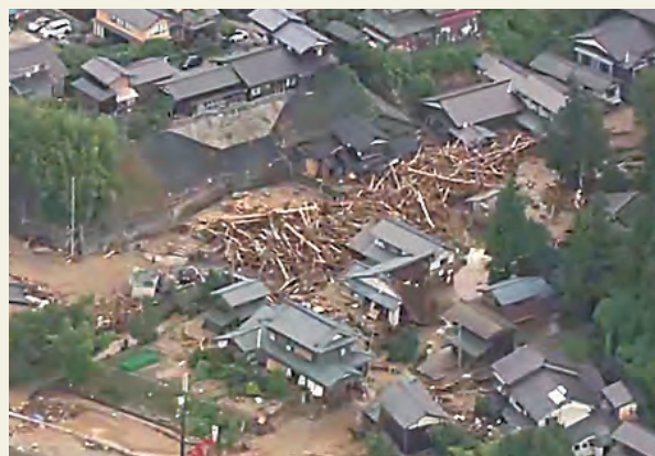
写真-3 新潟県村上市小岩内地区の土石流・流木被害
