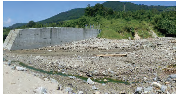
図-18 寒水砂防堰堤による土砂捕捉状況
