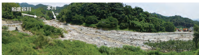
図-23 下流の流路工周辺の状況
