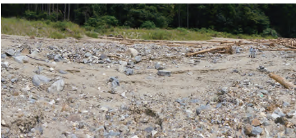
図-16 山ノ神砂防堰堤による土砂捕捉状況
