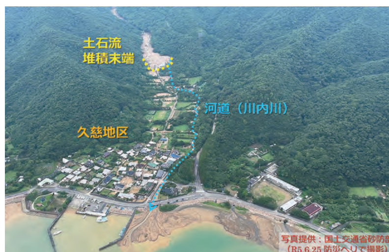
図-6 災害発生後の川内川と久慈地区の状況
