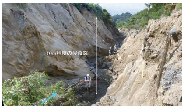
図-22 船底谷川砂防堰堤下流側の河床侵食状況
