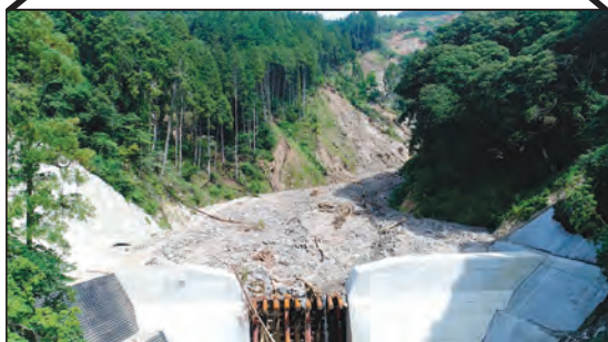
図-21 船底谷川第二砂防堰堤の土砂及び流木の捕捉状況
