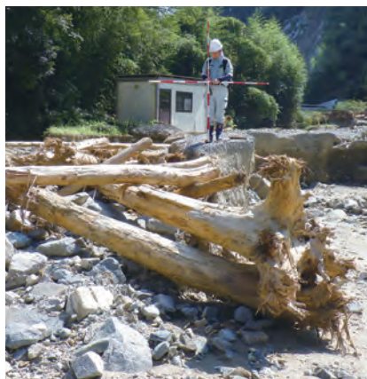
図-17 流路内の流木推積の状況
