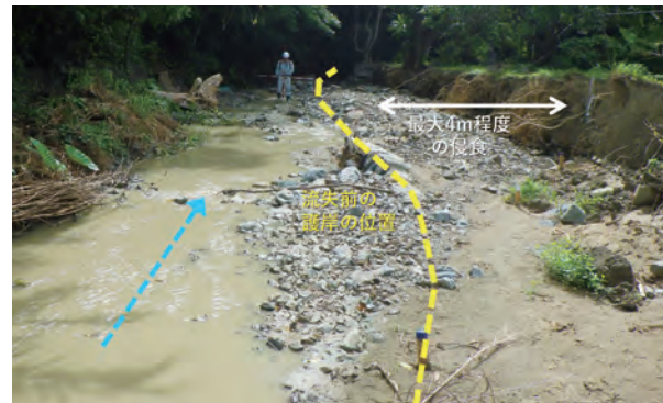
図-9 護岸の流出による農地の侵食
