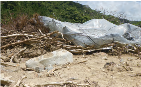
図-8 土石流堆積末端部のビニールハウスの被害
