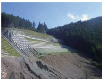
大規模地すべりでの現場施工事例 (地すべり対策工事)
