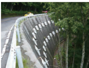
道路法面下での現場施工事例 (擁壁補強工事)
