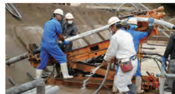
パッカー付アンカー一体挿入状況
