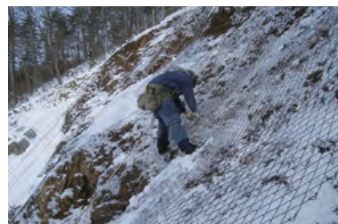
積雪時の施工状況
