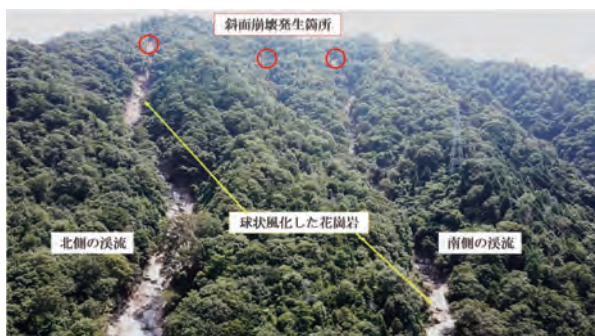
図-6 梅河団地北西の溪流の被災後の様子
