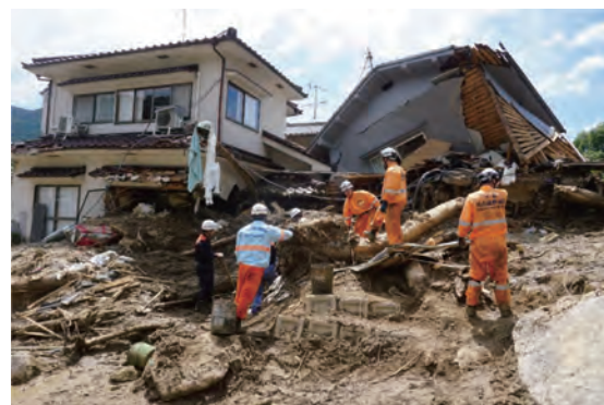
図-9 土石流分岐部の家屋の被災状態
