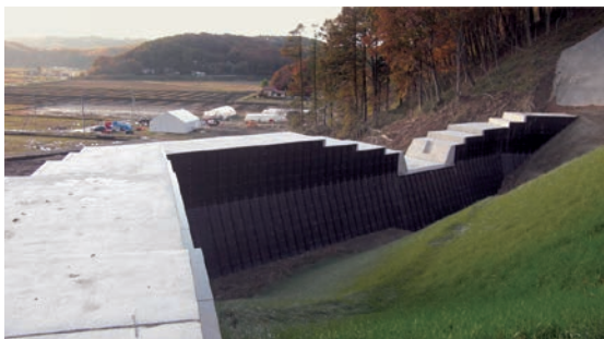
SBウォール工法 完成写真 (北海道胆振東部地震災害関連 上：下流側・下：上流面)
