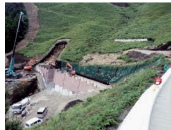
SBウォール工法 施工状況写真 (熊本地震災害関連 上：集中プラント・下：堰堤施工)
