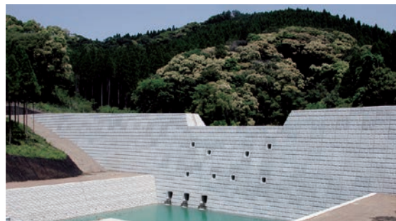
SBウォール工法 完成写真 (上：熊本県東小倉・下：宮崎県七瀬谷)
