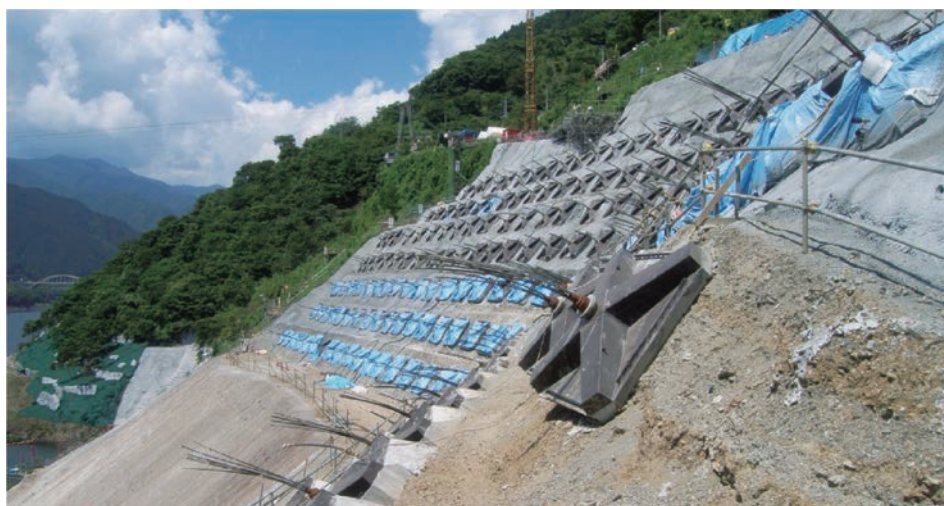
法面工事での施工事例
