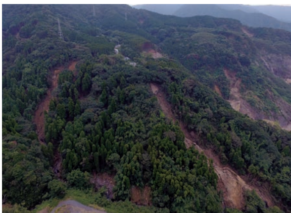
図-2 UAVで撮影した崩壊地 (平成28年台風16号に伴う土砂災害の発生後に撮影(鹿児島県 境川))
