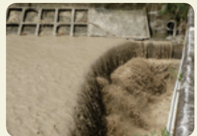
写真-5 油礮溪(慈恩橋)における出水状況
