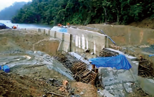
写真-2 越流開始前の余水吐施工状況
