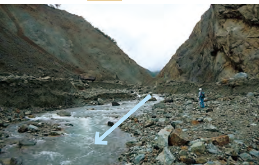
写真-5 崩壊した天然ダム位置を下流側から望む
