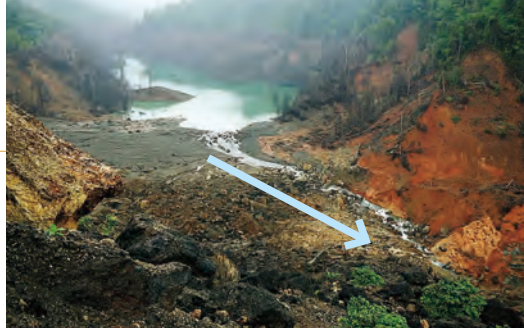
写真-4 天然ダム崩壊後の湛水地の状況
