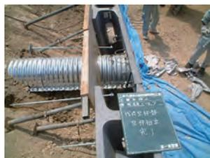
背面木製型枠状況(左：連結筋有 右：連結筋無)
