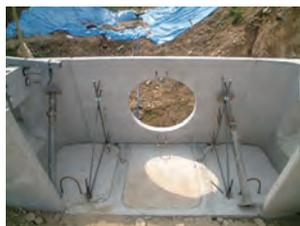
前面残存型枠パネル状況
