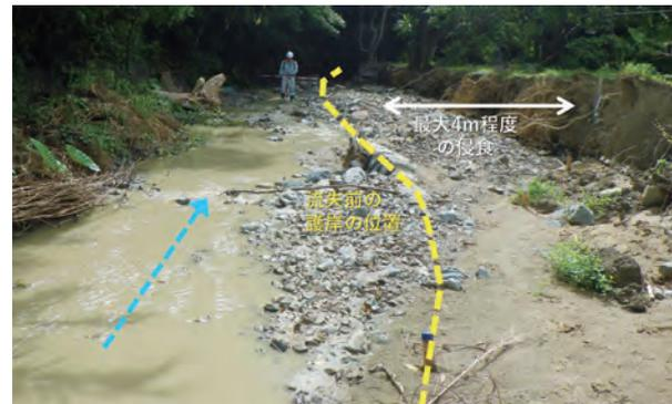
図-9 護岸の流出による農地の侵食
