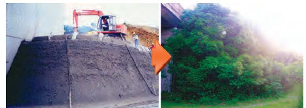
施工中(長繊維混入補強土吹付工)
