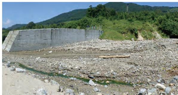
図-18 寒水砂防堰堤による土砂捕捉状況
