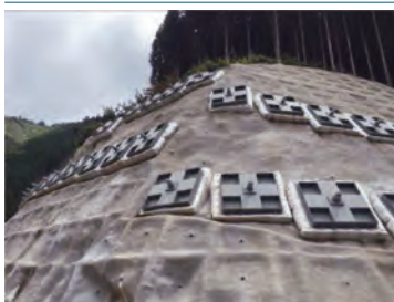
急傾斜地での現場施工事例 (林道復旧工事)
