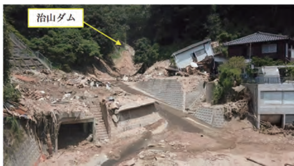
(a) 土石流が宅地に流れ込んだ地点の被災後
