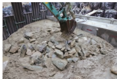
内部材の均し状況
