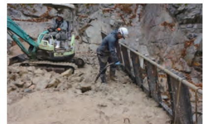
バイブレータによる締固め状況
