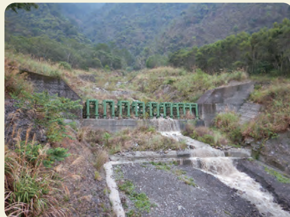
写真-4 (上)天然ダム決壊実験の様子。橋から発泡スチロールのボールを投入している。 (下)天然ダム実験箇所上流側には鋼製透過型砂防堰堤が整備されている。
