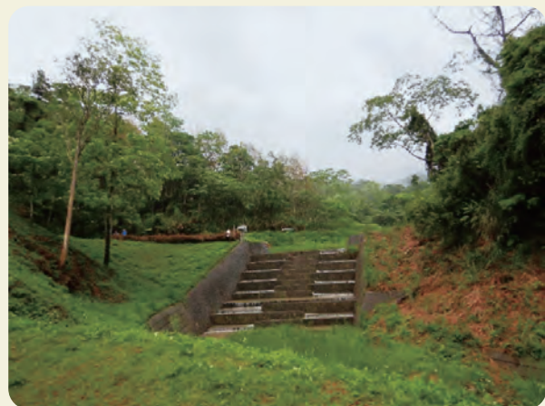
写真-6 東勢林場内(上)砂防堰堤と魚道、(下)落差工
