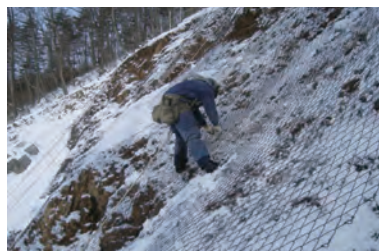
積雪時の施工状況
