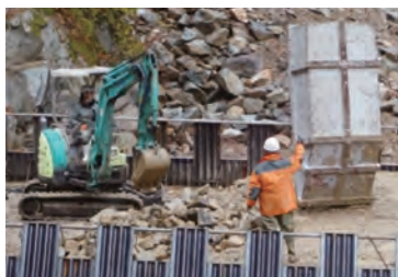
内部材(粗石)の投入状況
