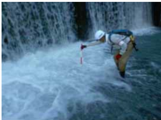
④砂防堰堤の水叩きの摩耗
