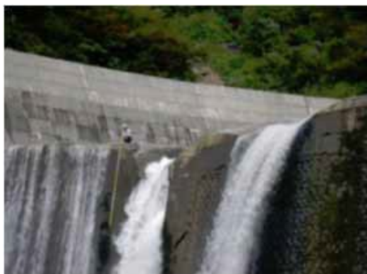
③砂防堰堤の本体水通り天端の摩耗
