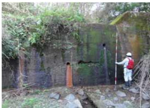
③砂防堰堤の本体水通り天端の摩耗
