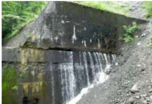
④砂防堰堤の水叩きの摩耗
