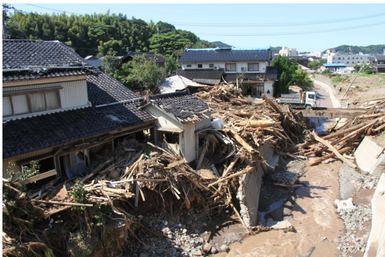
石川県輪島市久手川町 (石川県ホームページから)
