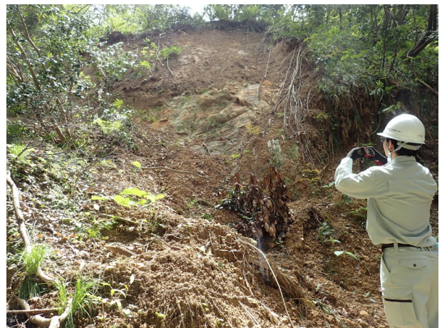
土口川流域内の斜面崩壊状況 (土口川2号砂防堰堤上流)
