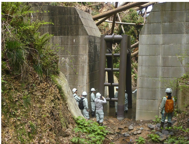
鋼製砂防堰堤の健全度調査 (土口川2号砂防堰堤)
