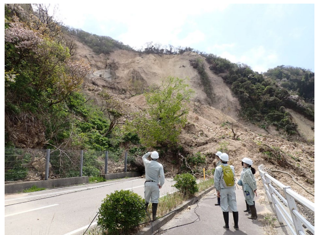
大規模崩壊の状況 (珠州市仁江町)
