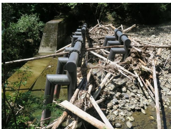
沼谷川砂防堰堤(和歌山県 有田川振興局) (提供:日鉄建材株式会社)
