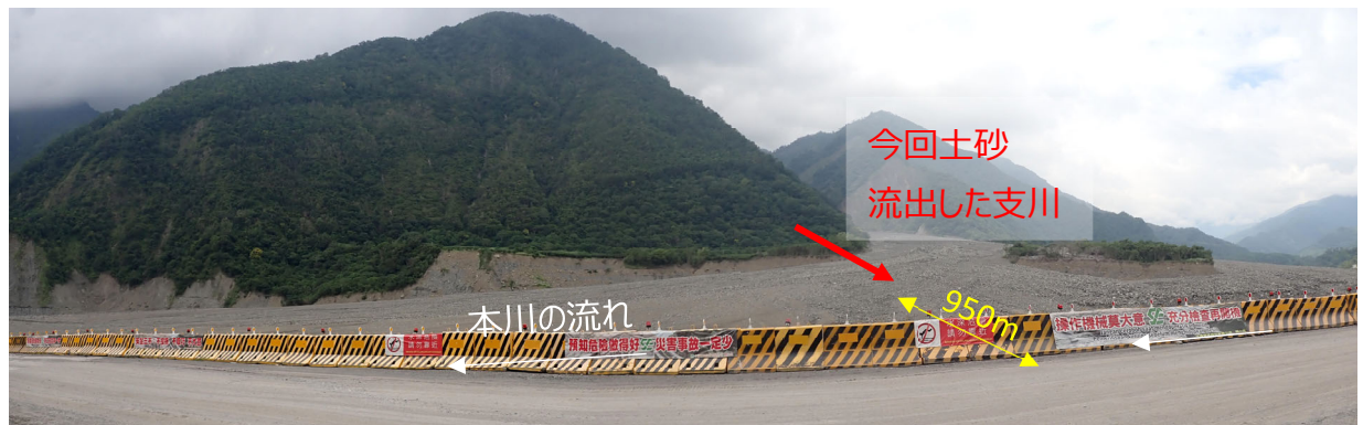
令和6年台風ケーミー(Gaemi)により大量に流出・堆積した状況（高雄市桃原区）
